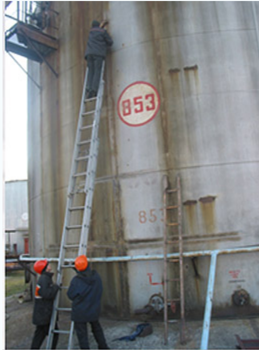
Неразрушающий (ультразвуковой) контроль сварных соединений и толщинометрия основного металла стенки обследуемого резервуара
