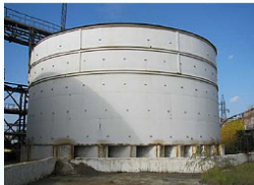
Общий вид обследуемого резервуара
