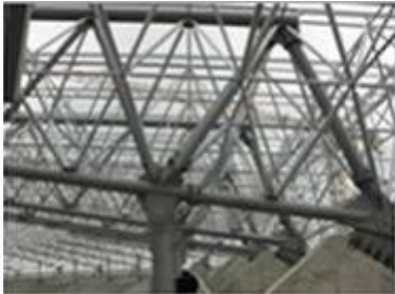
Общий вид наиболее ответственных узлов конструкции покрытия, подлежащих визуальному и инструментальному контролю
