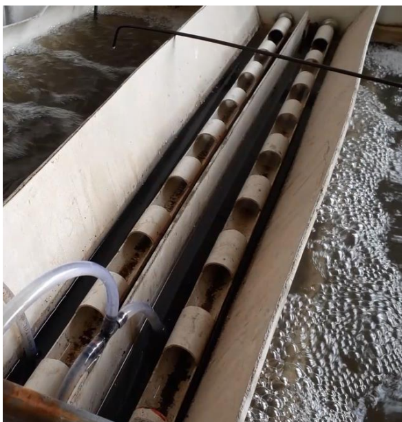
Рисунок 4.23 - Устройство сборных лотков.
