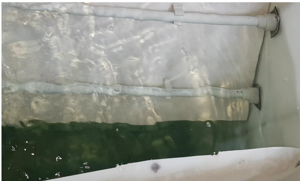
Рисунок 4.22 - Устройство наклонного козырька аэротенка-осветлителя
