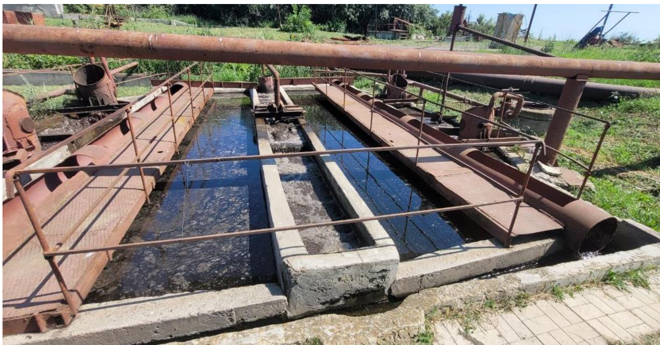
Рисунок 4.4 – Фото исследуемого аэротенка-отстойника №4.
