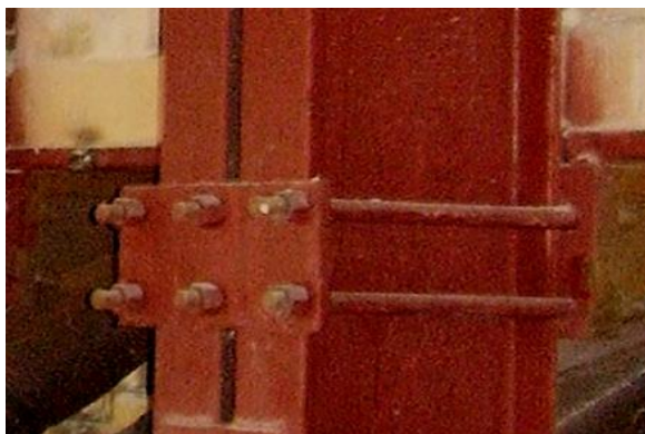
Рисунок 1.16 – Подвеска стен газопламенного пространства
