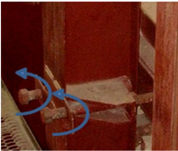
Рисунок 3.6 – Тяж в конструкции
