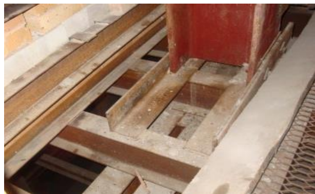
Рисунок 1.17 – Соединение колонн с балками днища
