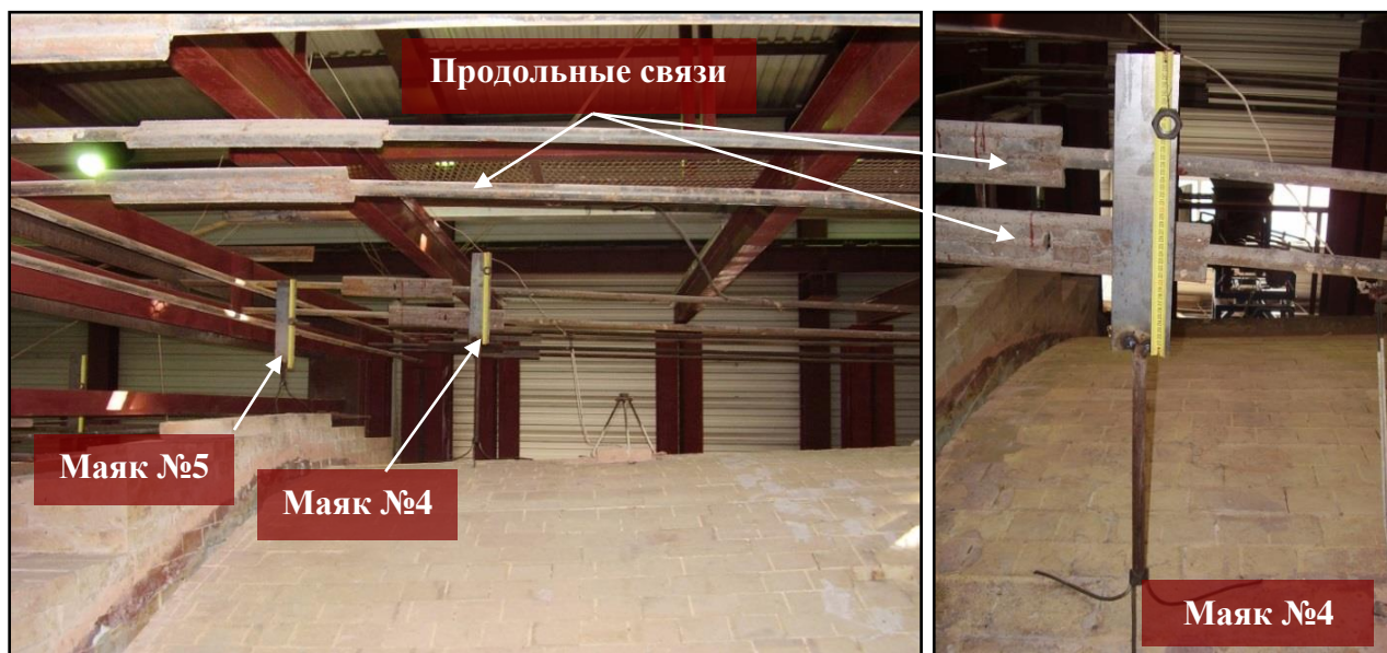
Рисунок 4.9 – Расположение контрольного маяка на наклонной секции главного свода стекловаренной печи
