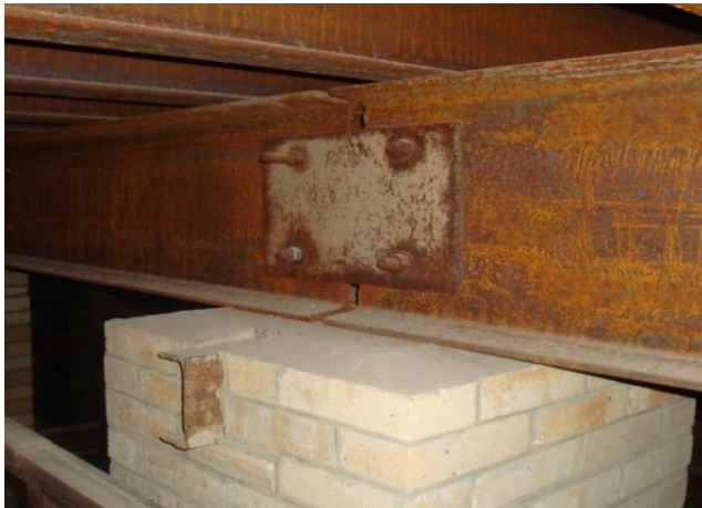
Рисунок 1.18 – Опорный узел продольных балок днища крупной ванной печи (съем 250 т/сут.)
