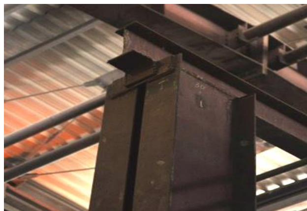
Рисунок 1.13 – Жесткое крепление поперечной связи
