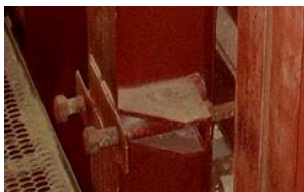
Рисунок 1.15 – Подвеска свода с возможностью регулирования
