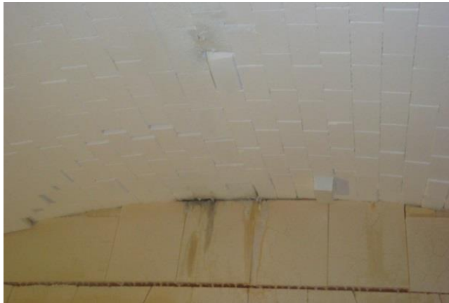
Рисунок 1.24 – Дефекты кладки свода регенеративной печи на 100 т/сут., при натурном обследовании после слива стекломассы
