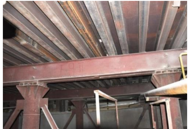
Рисунок 1.19 – Конструкция днища средней ванной печи (съем 100 т/сут.)
