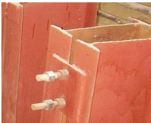
Рисунок 1.12 – Резьбовое соединение с регулировкой сверху
