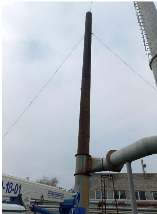
Рисунок 1.3 – Стальные дымовые трубы с подземным (а) и наземным (б) примыканием газохода
