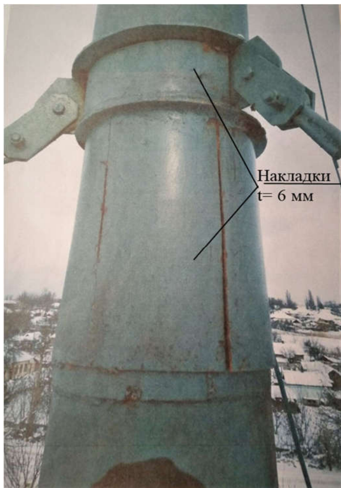
Рисунок 5.10 – Усиление лацменного узла накладками
