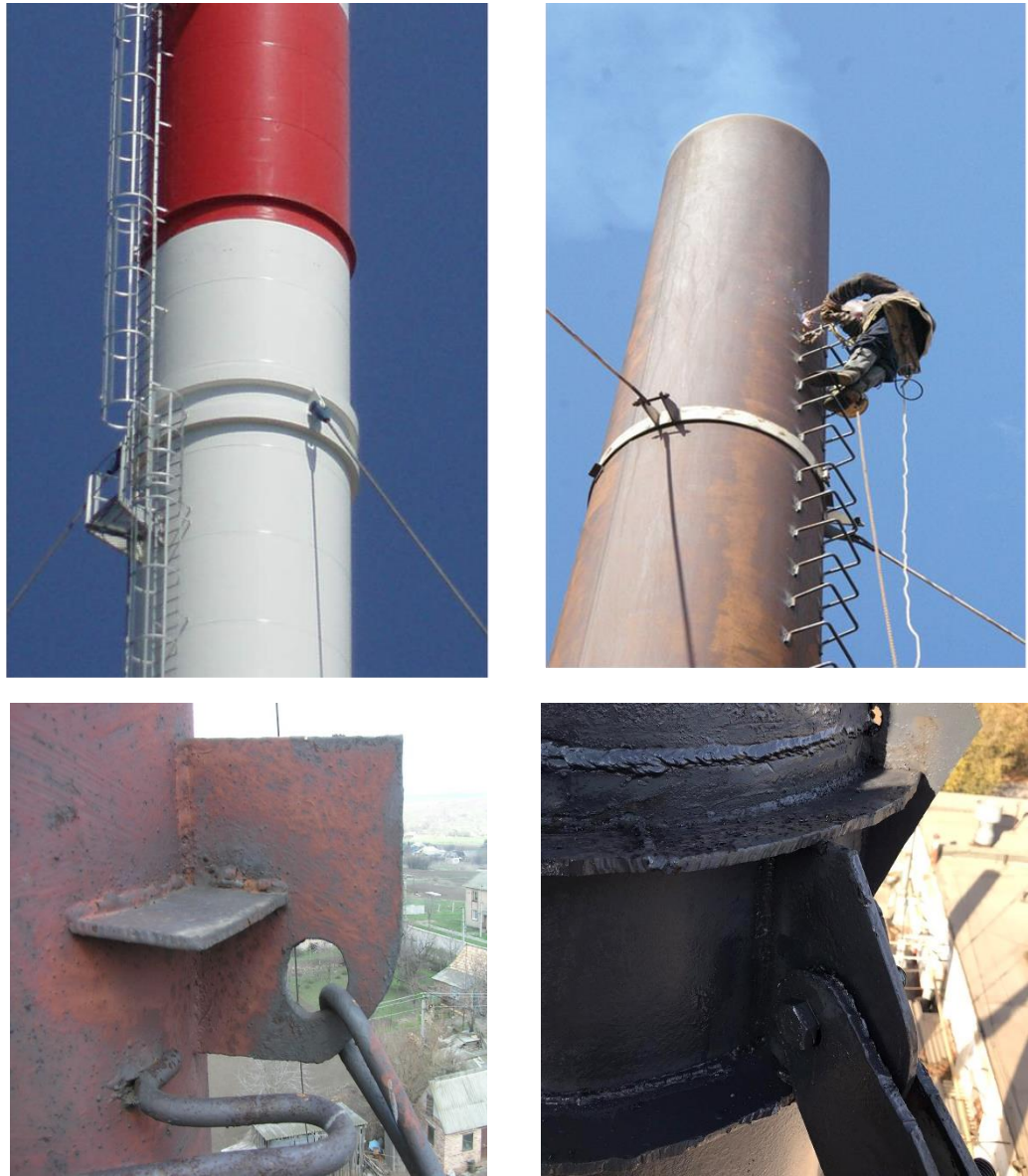
Рисунок 1.5 – Виды лацменных узлов дымовых труб на оттяжках
