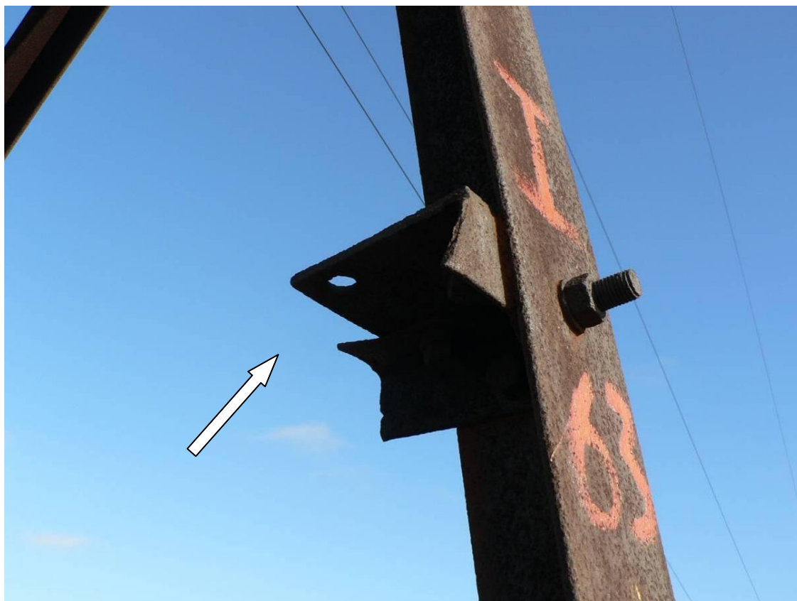
Рисунок Б.1.1 - Отсутствие диафрагм жесткости нижней секции
