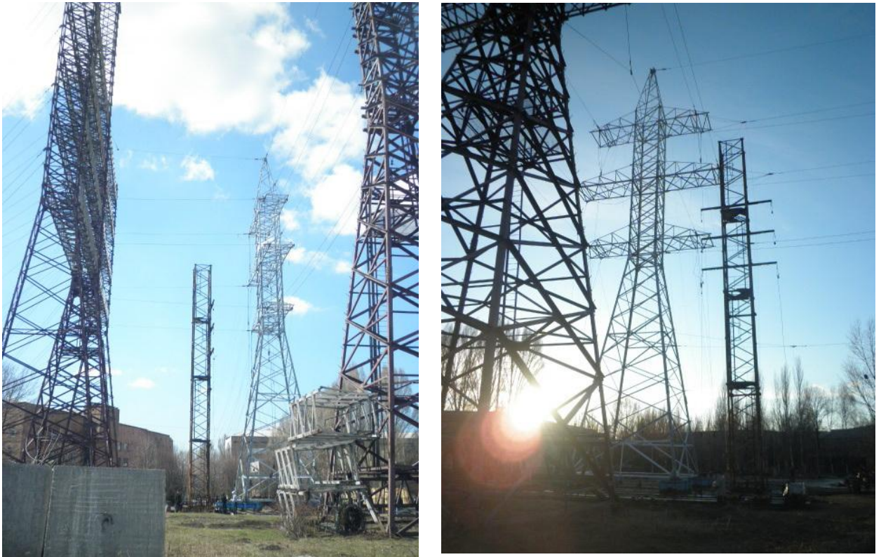
Рисунок 3.7 - Общий вид опоры, подготовленной для проведения эксперимента, на Полигоне ДонНАСА.
