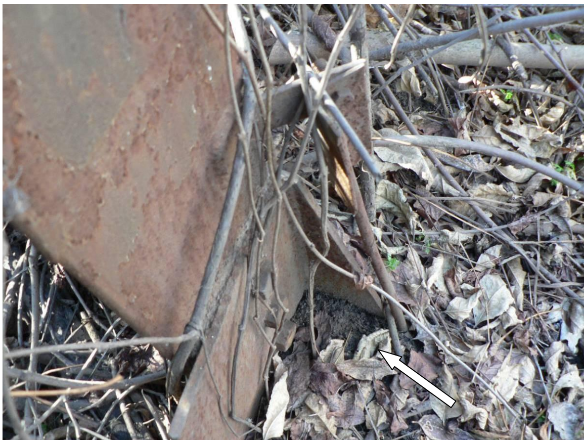
Рисунок Б.1.12 - Отсутствие горизонтальной планировки
