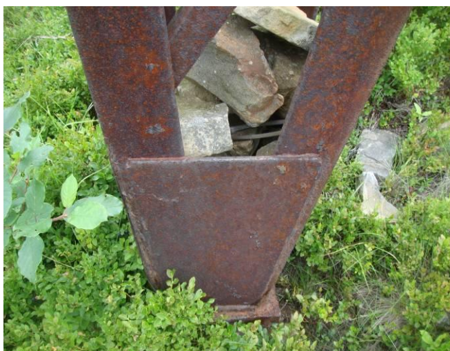
Рисунок Б.3.15 - Фундаменты засыпаны грунтом
