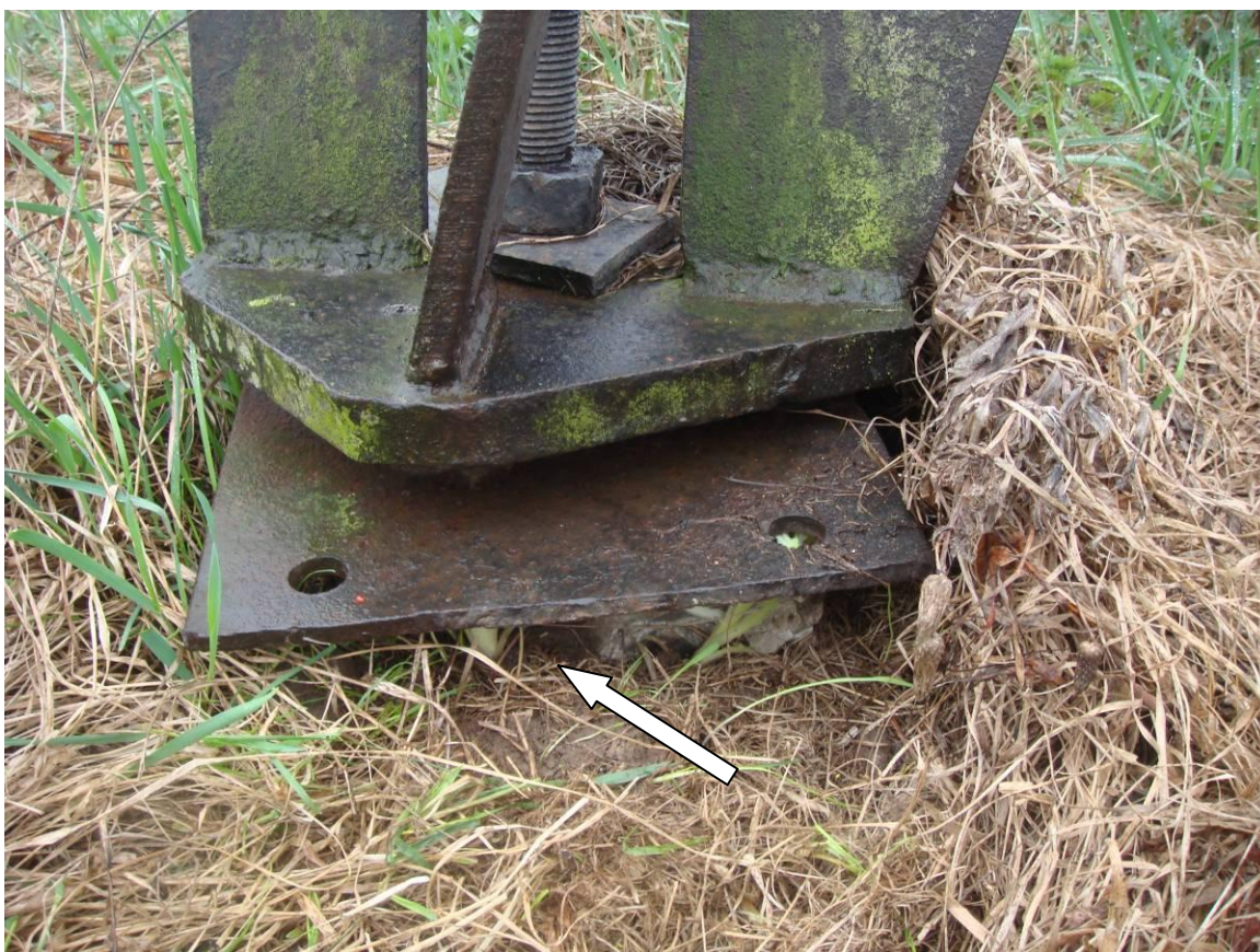
Рисунок Б.2.18 - Фундаменты засыпаны грунтом
