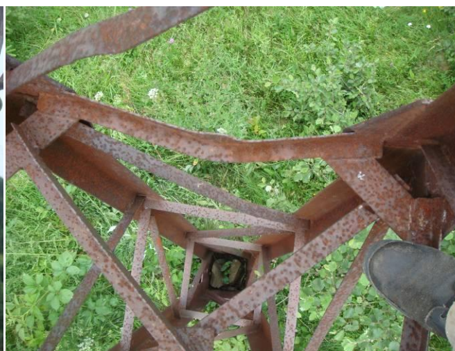
Рисунок Б.3.28 - Деформация стержней раскосов
