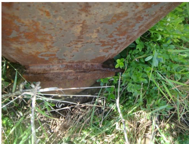
Рисунок Б.3.1 - Фундаменты засыпаны грунтом
