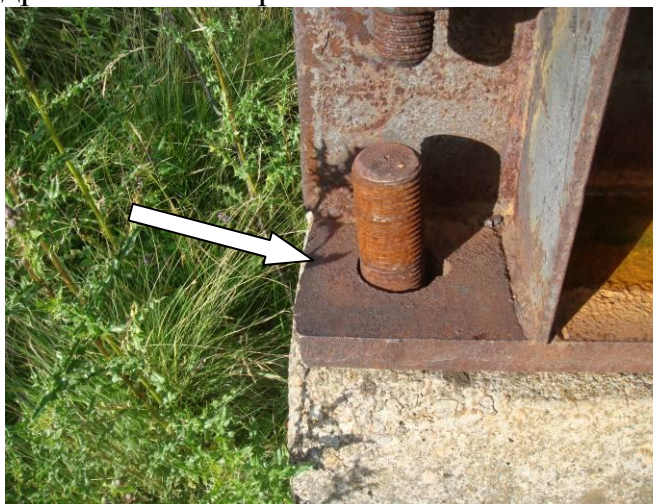
Рисунок Б.3.35 - В оп.341 отсутствует одна гайка анкерного болта
