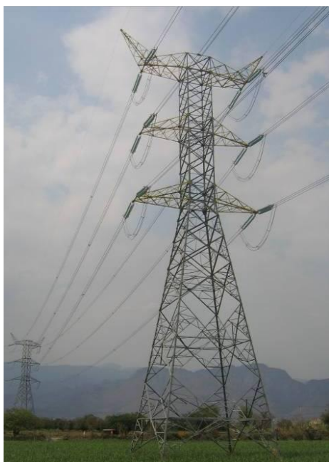
Рисунок 1.11 - Анкерная опора ВЛ (Франция).
