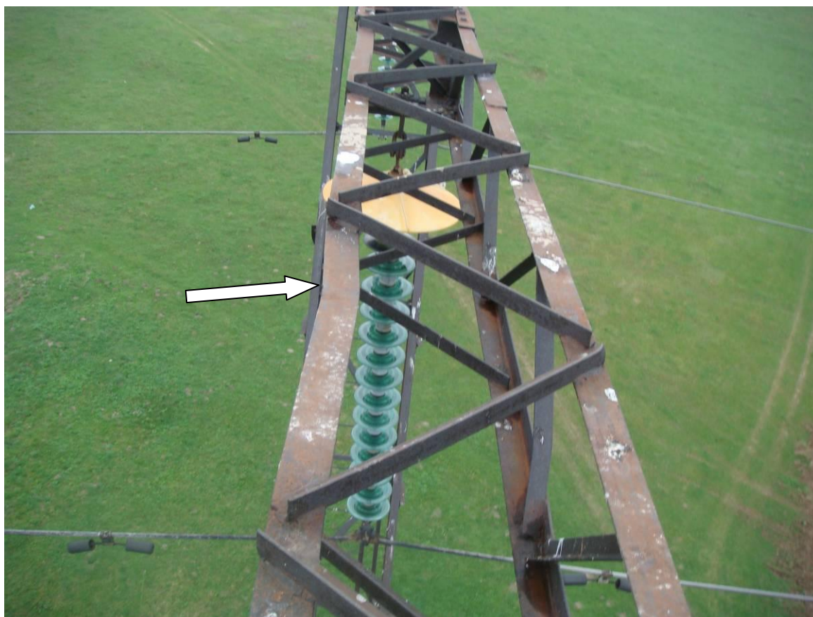
Рисунок Б.2.9 - Деформация стержней решетки и поясов
