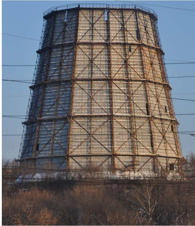
Рисунок 1.2 – Башенная десятигранная металлическая градирня пирамидальной формы («Донецкий металлургический завод»)
