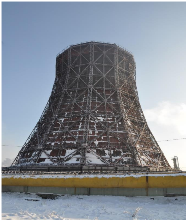
Рисунок 1.3 – Башенная двенадцатигранная металлическая градирня гиперболической формы («Ясиновский коксохимический завод»)
