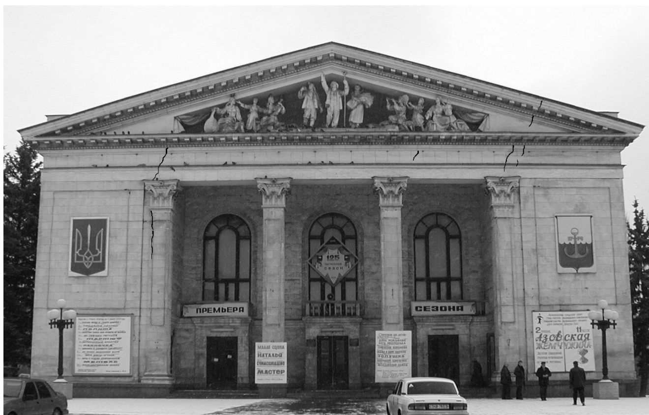
Рис. 4.7 Главный фасад с повреждениями на момент обследования (трещины на фотографии подретушированы, ширина раскрытия трещин до 7 мм)
