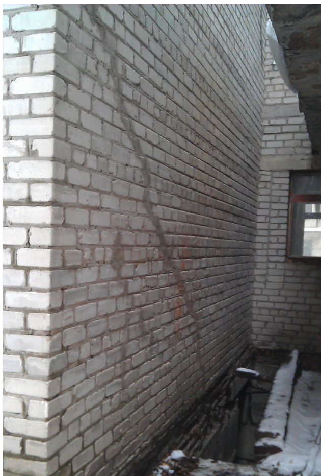
Рис. 4.14 Трещины в торцевой стене над входом в подвал
