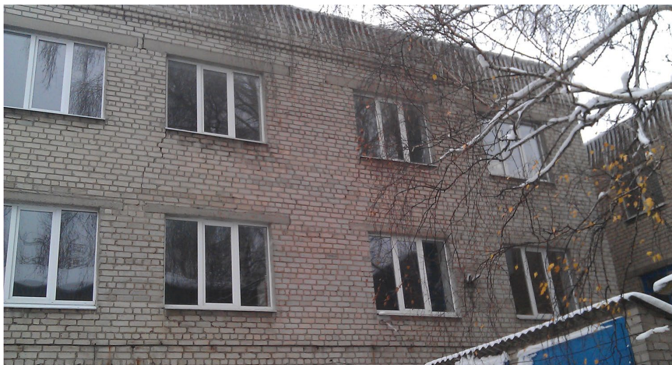
Рис. 4.15 Трещины в продольной наружной стене
