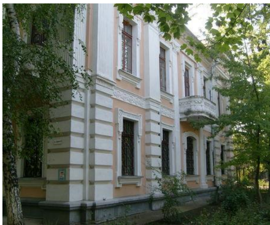
Рисунок 7 - Здание окружного суда в г. Бендеры
