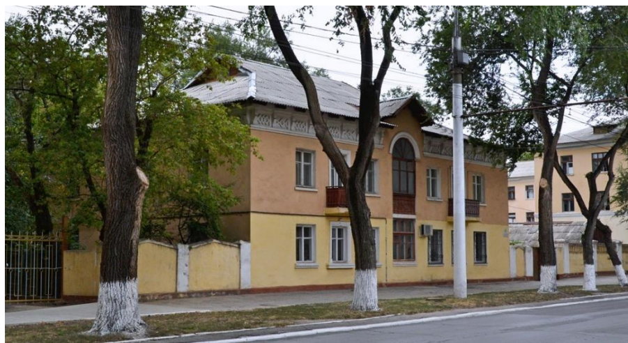
Рисунок 4 - Жилой дом по улице 25 Октября, 111. 1941-1957 годов
