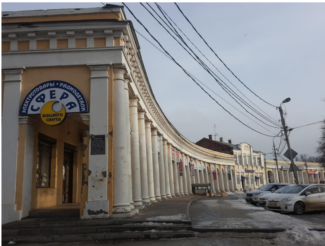
Рисунок 5 - Торговые ряды. Перспектива колоннады северо-восточной части полукруга. Современное состояние
