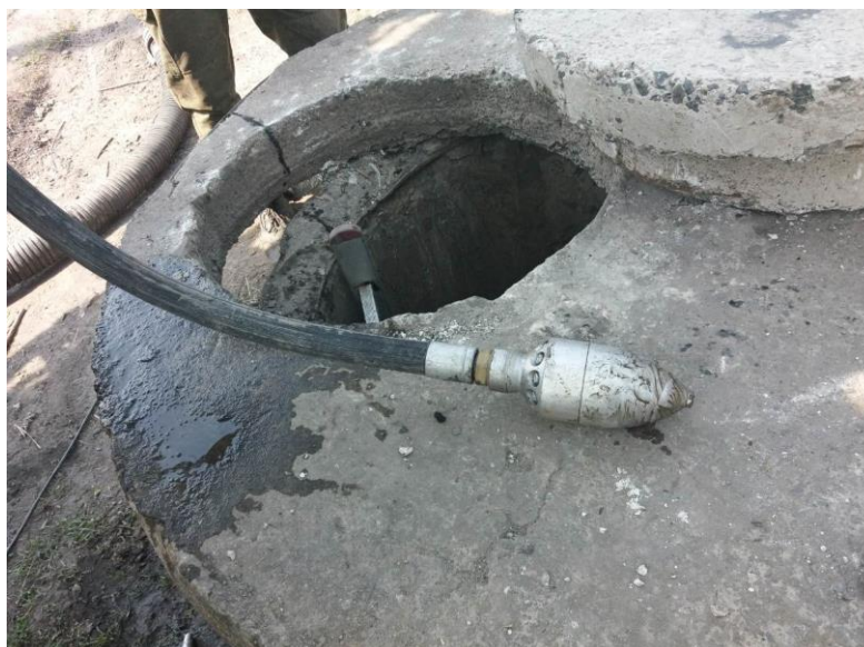
Рисунок 4. - Насадка форсунка-торпеда после прочистки коллектора
