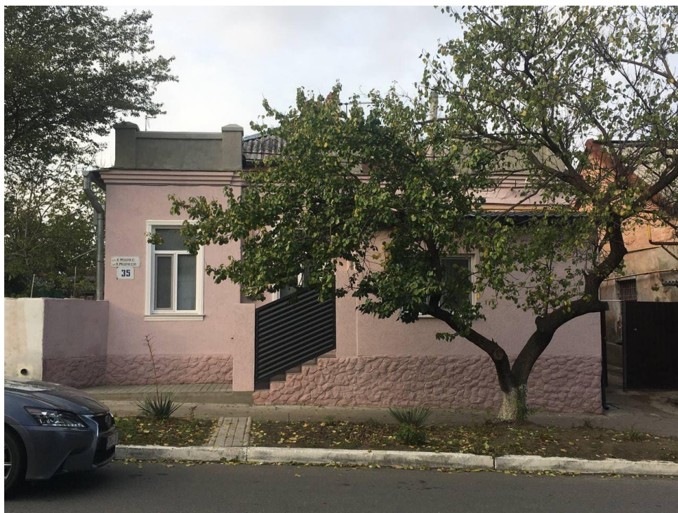
Рисунок 7 - Жилой дом по ул. Карла Маркса 35.
