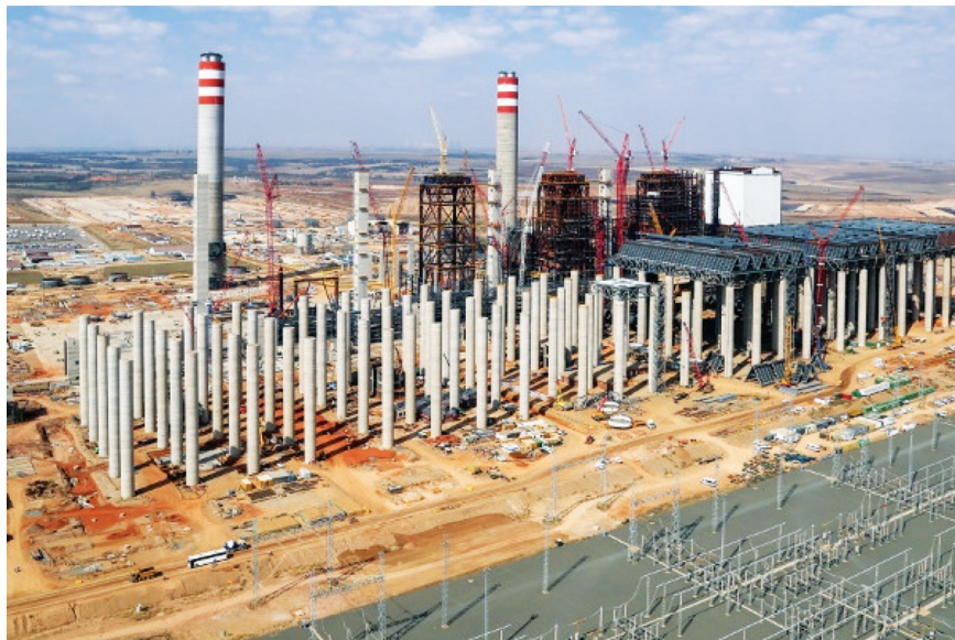
Kusile Power Station. 4,800 MW Заказчик – ESKOM (Южная Африка). Основной подрядчик – Black & Veatch Corporation. Одна из крупнейших угольных электростанций в мире, где одновременно возводятся 6 блоков по 800 МВт каждый. Впервые в Южной Африке используется сверхкритический режим, мокрая серогазоочистка и воздушный конденсатор
