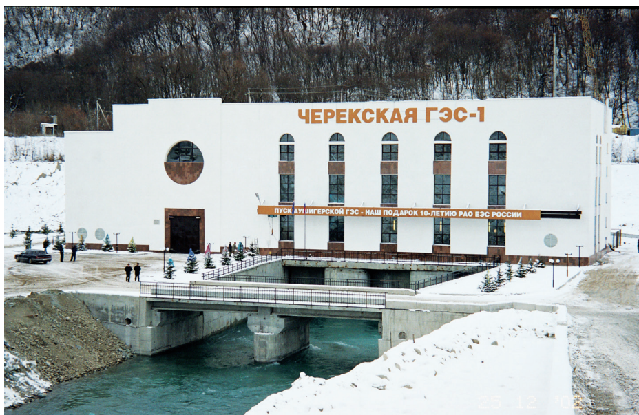
Административное здание Черекской ГЭС
