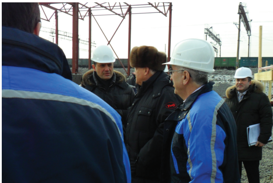
Встреча с президентом РЖД В.И. Якуниным на строительстве рельсосварочного завода, г. Челябинск
