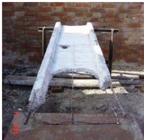
Рис. 1. Разрушенная плита покрытия Р-10.
