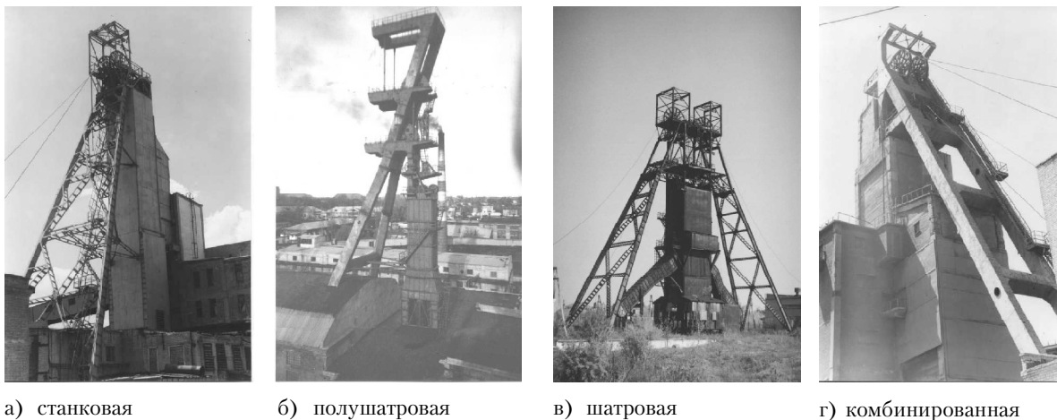
Рис 1. Типы конструктивных схем шахтных копров.
