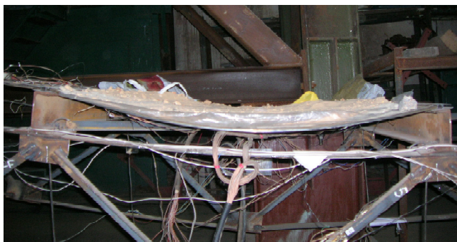
Рис. 3. Деформирование ограждающей конструкции по схеме 2.
