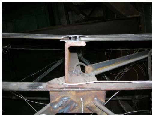
Рис. 2. Узел крепления пластика к несущей конструкции модели.
