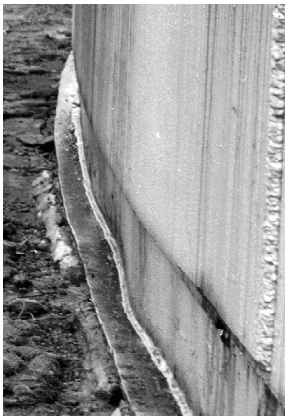
Рис. 1. Гофры по линии сопряжения стенки с дном.
