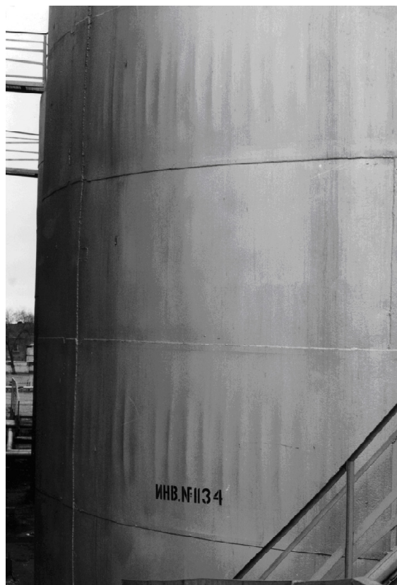
Рис. 2. Вертикальные гофры по свободной поверхности поясов цилиндрической стенки.
