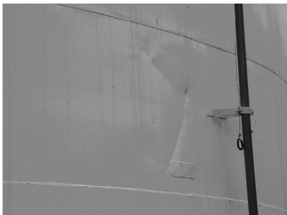
Рис. 3. Сосредоточенные погнутости по поверхности цилиндрической стенки.
