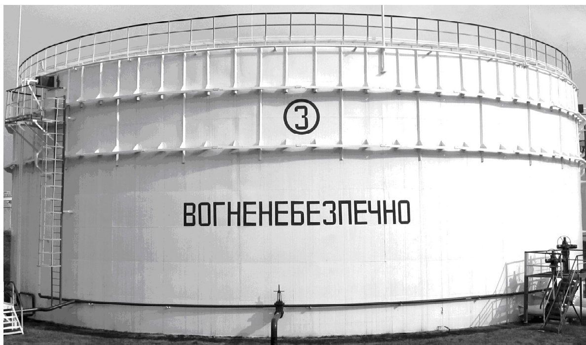
Рис. 5. Усиление резервуара объемом 10 тыс. м 3 .
