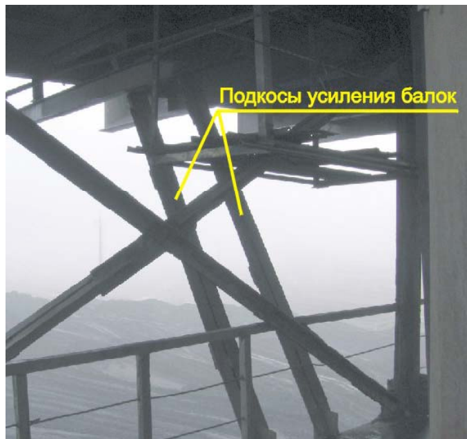
Рис. 4. Выполненное усиление конструкций консольной части моста галереи:
