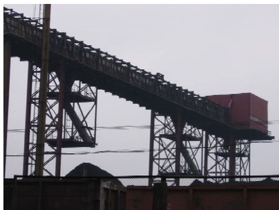
Рис. 1. Общий вид моста галереи.
