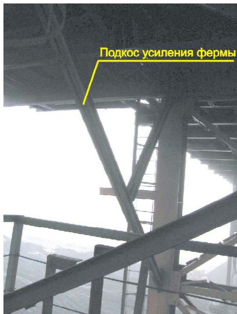
Рис. 4. Выполненное усиление конструкций консольной части моста галереи:
