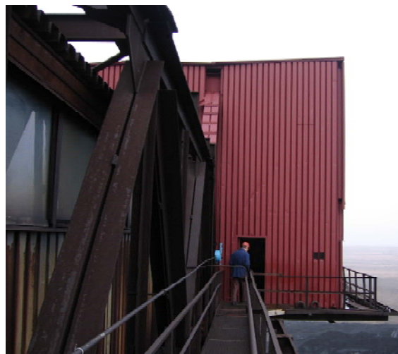
Рис. 2. Конструкции консольной части крайнего пролета моста галереи.
