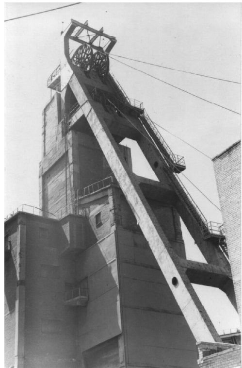
Рис. 7. Общий вид объектов динамических испытаний: а) копер клетового подъёма рамной системы; б) копер клетового подъёма станковой системы; в) копёр скипового подъёма комбинированной системы; г) рамный комбинированный копёр скипового подъёма.
