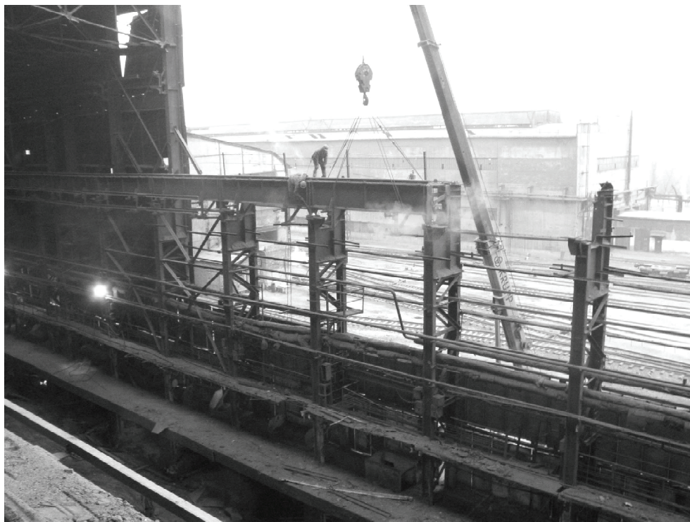
Рис. 5. Демонтаж подкрановых балок.
