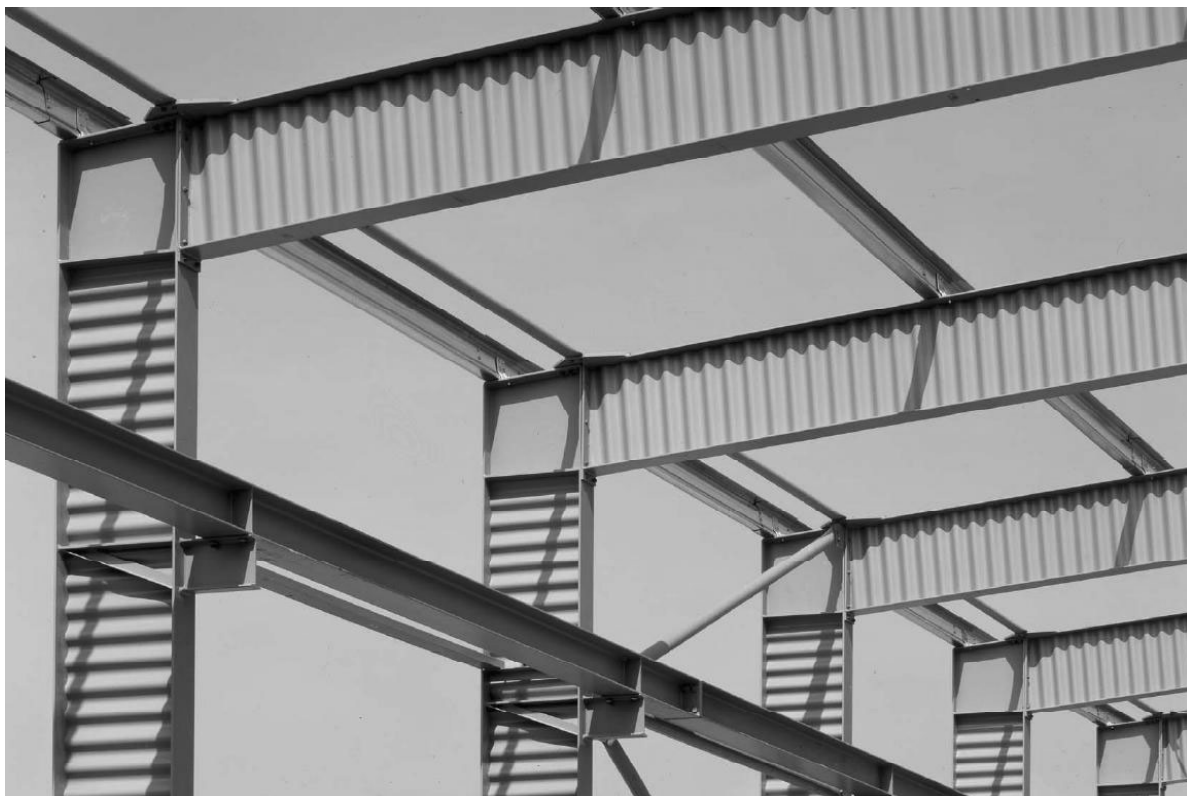
Рис.1. Рамы двутаврового сечения с гофрированной стенкой.
