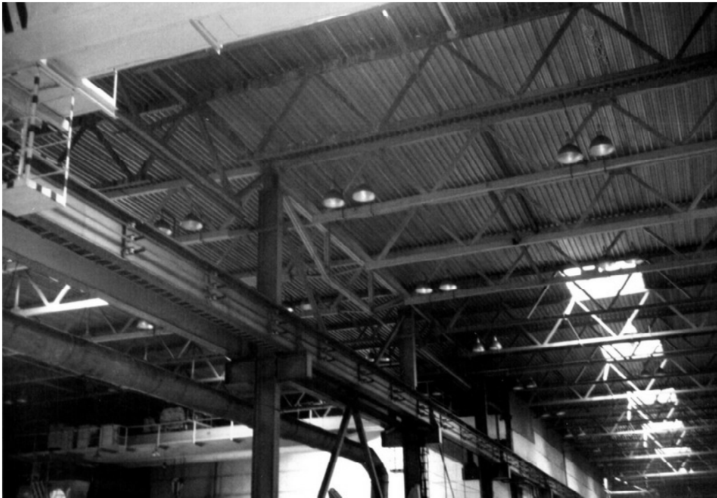
Рис.4. Підкрів'яна балко-ферма L=12\text{м} . Завод експериментальних механічних випробувань м. Львів, 2004 р.
