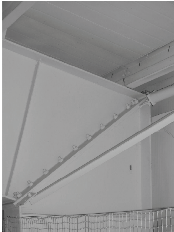
Рис. 6. Карнизный узел. а – проектная схема; б – фактический узел.
