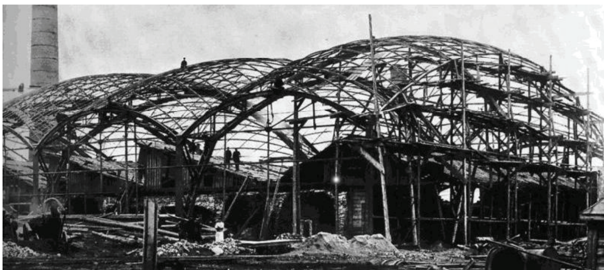
Рис. 2. Сетчатые оболочки двоякой кривизны конструкции В. Г. Шухова на Выксунском металлургическом заводе, 1987 г.
