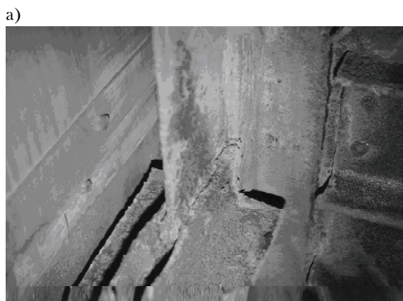
Рис. 2. Коррозионные повреждения узлов ферм станка шахтного копра при потерях сечений более 40%: а) деформации элементов и разрушение сварного шва; б) трещины в сварных швах.
