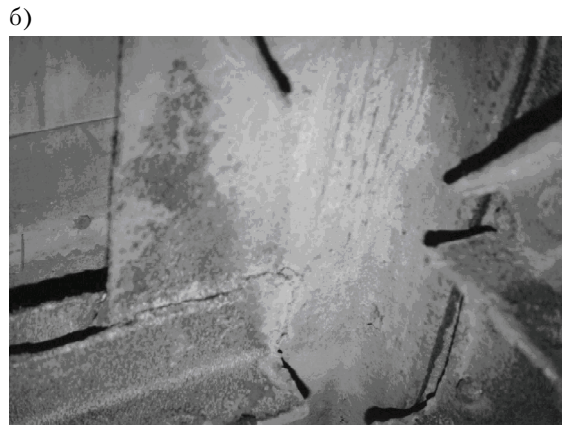
Рис. 2. Коррозионные повреждения узлов ферм станка шахтного копра при потерях сечений более 40%: а) деформации элементов и разрушение сварного шва; б) трещины в сварных швах.
