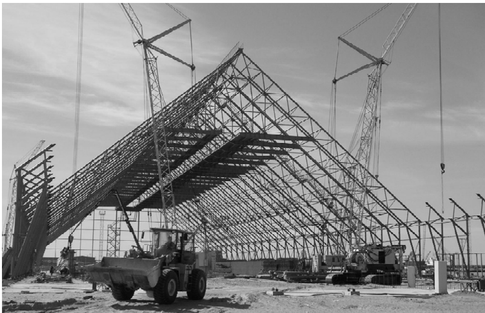
Рис. 1. Зведення поперечних рам каркасу складської будівлі.
