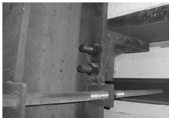
Рис. 2. Крепление опорного уголка к колонне.
