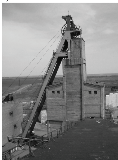
Рис. 1. Общий вид комплекса сооружений реконструируемой шахтной подъемной установки: а — здание подъемных машин; б — шахтный копёр и надшахтное здание.
