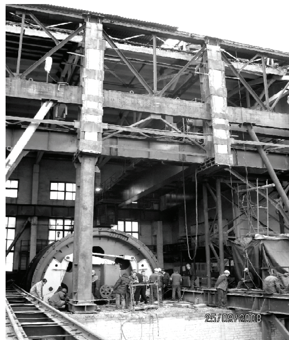
Рис. 13. Общий вид монтажного проёма после монтажа одной из съёмных колонн.
