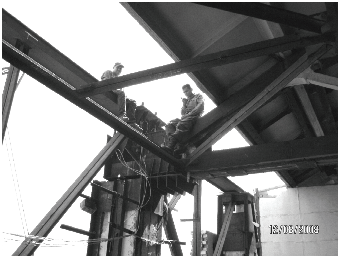
Рис. 11. Подъём железобетонных стропильных ферм винтовыми домкратами.
