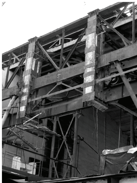
Рис. 12. Удаление участков железобетонных колонн в осях А-4 и А-5: а — последовательность резов; б — общий вид монтажного проёма после частичного удаления колонн.
