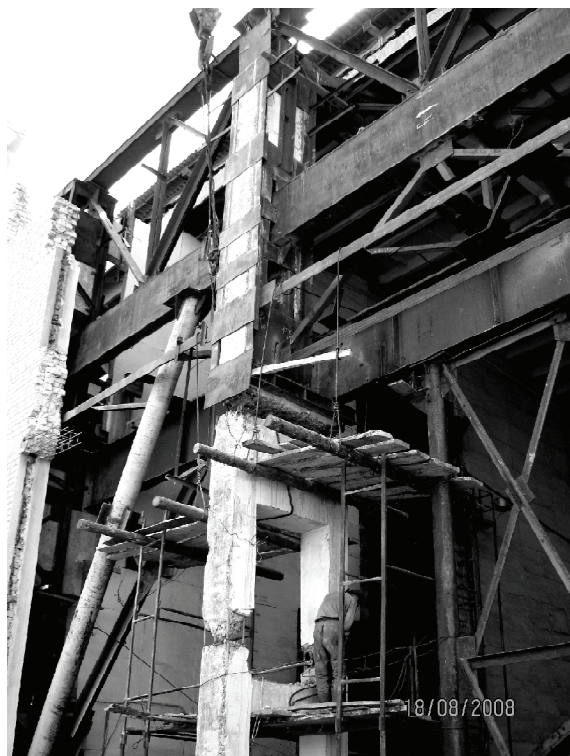
Рис. 12. Удаление участков железобетонных колонн в осях А-4 и А-5: а — последовательность резов; б — общий вид монтажного проёма после частичного удаления колонн.
