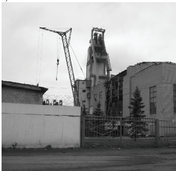
Рис. 1. Общий вид комплекса сооружений реконструируемой шахтной подъемной установки: а — здание подъемных машин; б — шахтный копёр и надшахтное здание.
