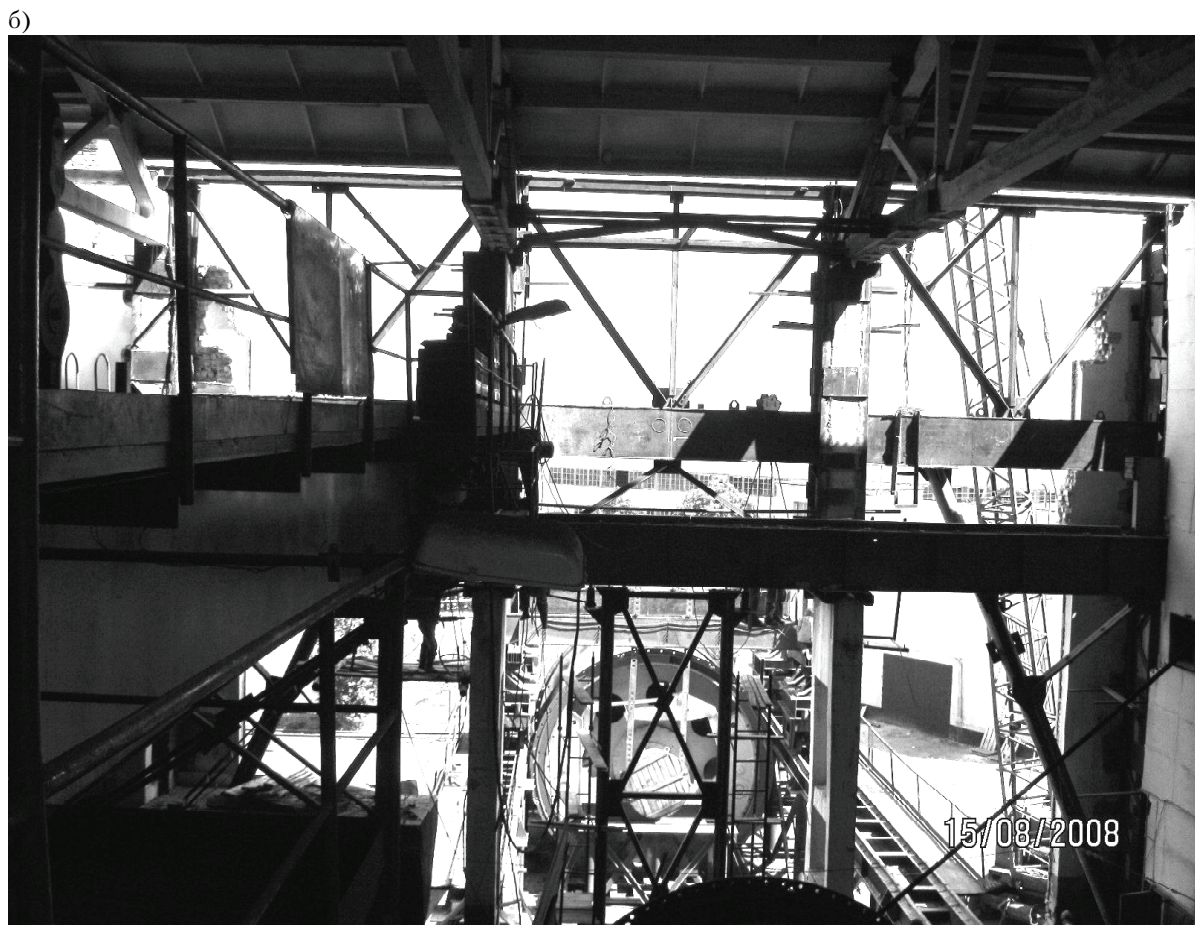
Рис. 10. Общий вид подкраново-подстропильной системы после третьей стадии монтажа: а — вид снаружи здания; б — вид изнутри с уровня подкрановых конструкций.
