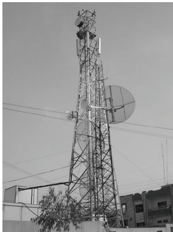
Рис. 1.4. Общий вид решетчатой башни уголкового сечения.
