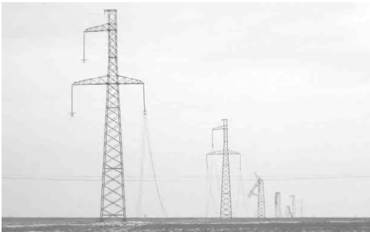
Рис. 2. Общий вид поврежденного участка ВЛ 330 кВ "Каховская – Джанкой".
