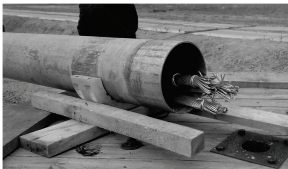
Рисунок 8. Укладка внутрь трубы нескольких канатов с целью гашения ее возможных колебаний.
