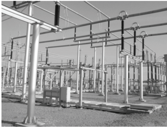
Рисунок 1. Современные ОРУ с жесткой ошиновкой (ЗАО «ЗЭТО») в России.
