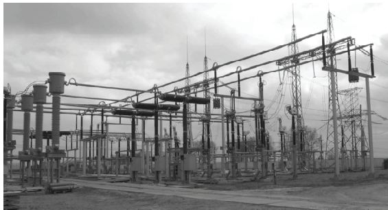
Рисунок 2. Конструкции жесткой ошиновки ПС «Киевская».
