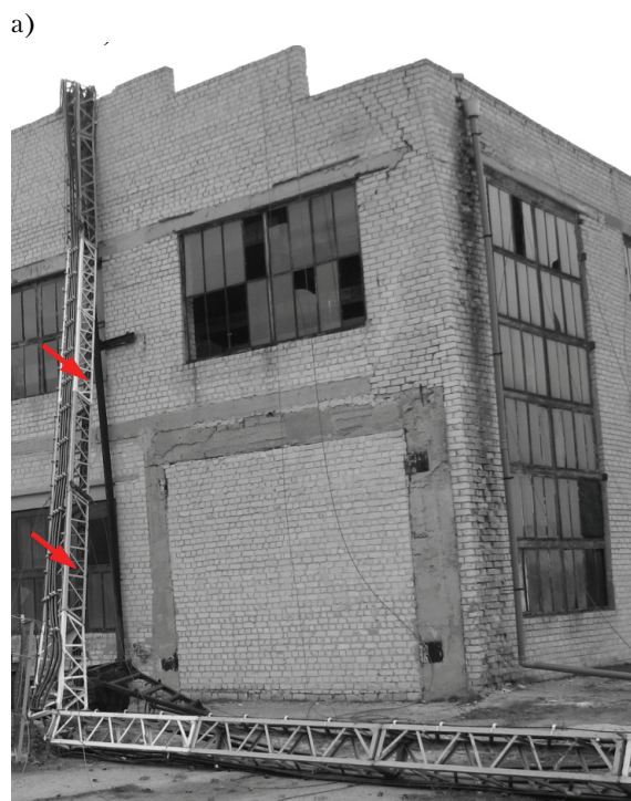
Рисунок 5. Аварии мачт мобильной связи в с. Слободка (а) и пгт. Горностаевка (б).
