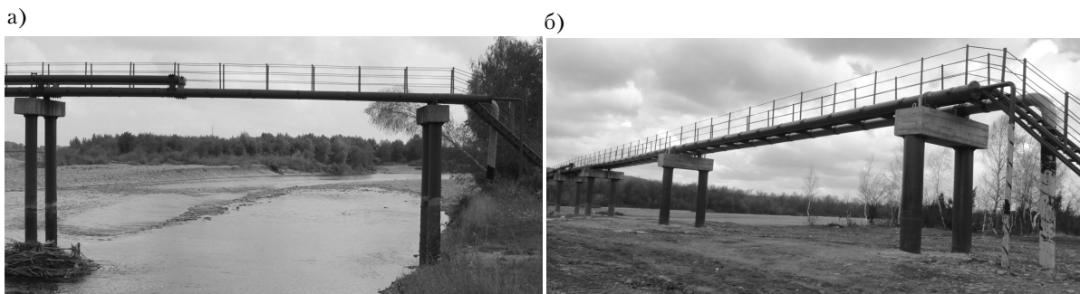
Рисунок 1. Балковий перехід: а) до реконструкції; б) після реконструкції.
