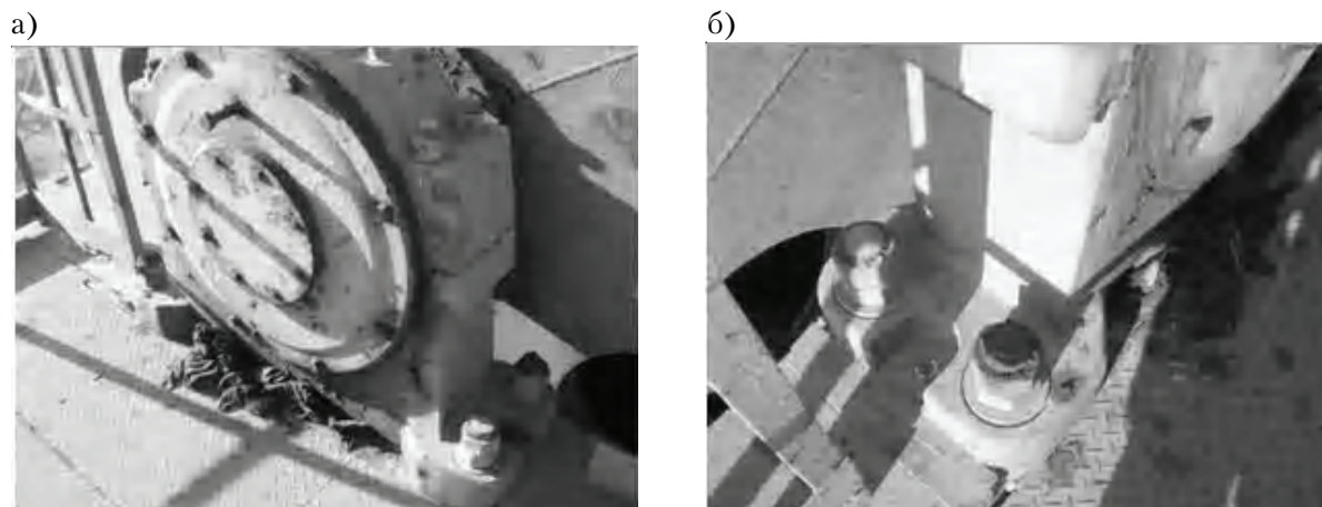
Рисунок 2. Узел опирания подшипника направляющего шкива.
