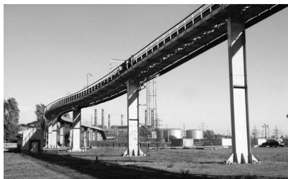
Рисунок 1. Основные конструктивные части конвейерных галерей: 1 – пролётное строение, 2 – опоры, 3 – фундаменты.
