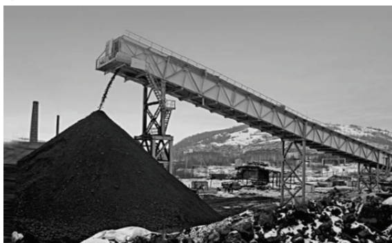
Рисунок 1. Основные конструктивные части конвейерных галерей: 1 – пролётное строение, 2 – опоры, 3 – фундаменты.
