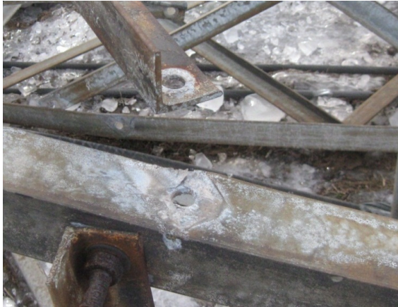
Рисунок 1. Срез болта в одноболтовом соединении раскоса с поясом опоры ЛЭП.
