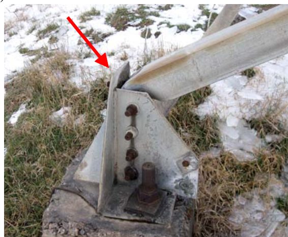
Рисунок 1. Повреждения опор вследствие аварий на ВЛ 330 кВ (АР Крым): а) при обрыве гирлянды изоляторов верхней траверсы; б) каскадное разрушение опор в средней части ствола; в) излом поясов ствола опоры; г) в месте болтового соединения пояса с базой.
