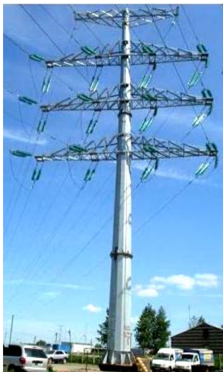
Рисунок 6. Модифицированные опоры ВЛ: а) многоцепная опора ВЛ 220 кВ; б) опора многоцепная комбинированная ВЛ 380 – 220 – 110 кВ.
