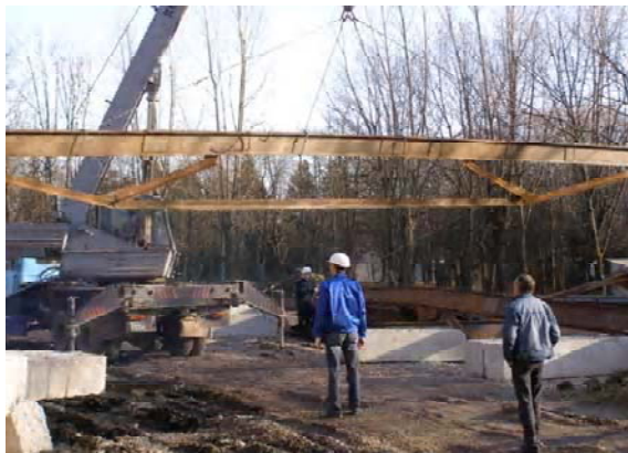
Рисунок 1. Монтаж малоелементної комбінованої шпренгельної ферми, Україна.
