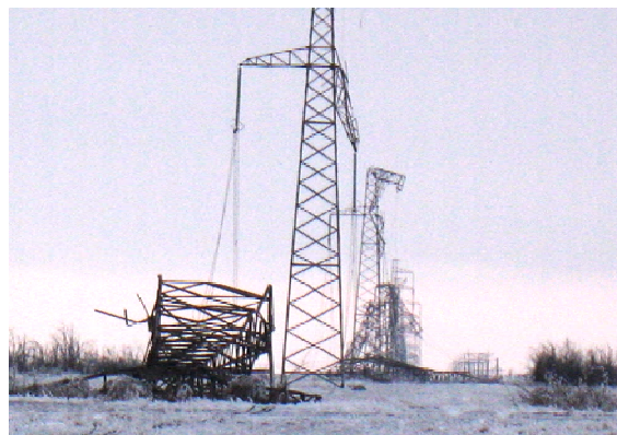
Рисунок 1. Каскадное разрушение металлоконструкции опор на участке ВЛ 330 кВ «Каховская – Джанкой»: а) вид со стороны опоры № 307; б) вид со стороны опоры № 311.
