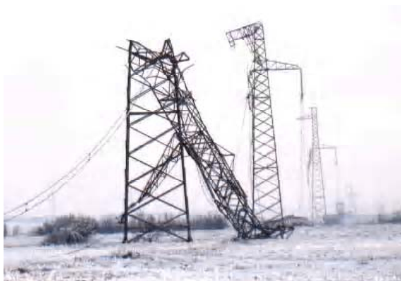
Рисунок 1. Каскадное разрушение металлоконструкции опор на участке ВЛ 330 кВ «Каховская – Джанкой»: а) вид со стороны опоры № 307; б) вид со стороны опоры № 311.
