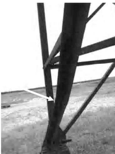
**Рисунок 5.** Общая погнутость опорного раскоса.
