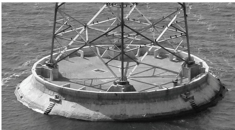
**Рисунок 7.** Общий вид фундамента опоры № 19 ВЛ 330 кВ «ЗаТЭС–Ферросплавная».
