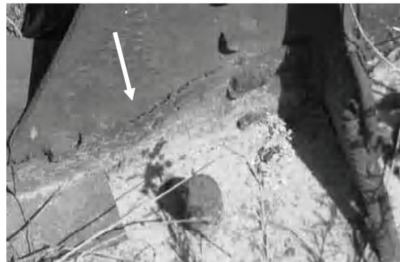
**Рисунок 4.** Коррозионное поражение опорных фасонек из-за наличия грунта в уровне среза фундамента.
