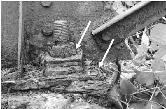
**Рисунок 3.** Коррозионное поражение до 2,0 мм опорных фасонек, анкерного болта и гайки.
