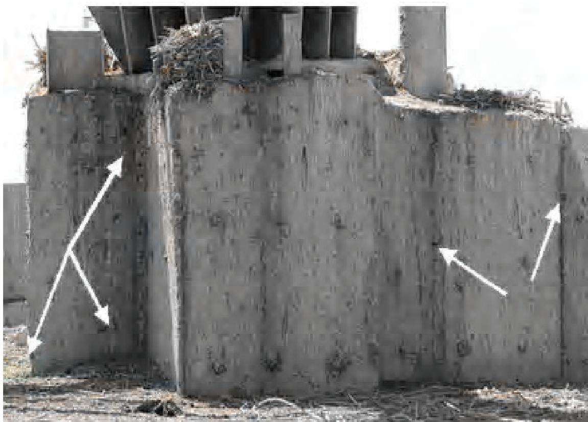
**Рисунок 9.** Наличие полостей глубиной до 15–20 мм.
