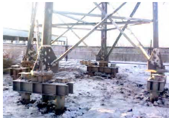
Рисунок 6. Подножник опоры ВЛ.
