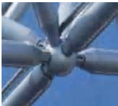
Рисунок 4. Конструктивное решение узлов со сферическими коннекторами: а) система «Кисловодск»; б) система «БрГТУ».
