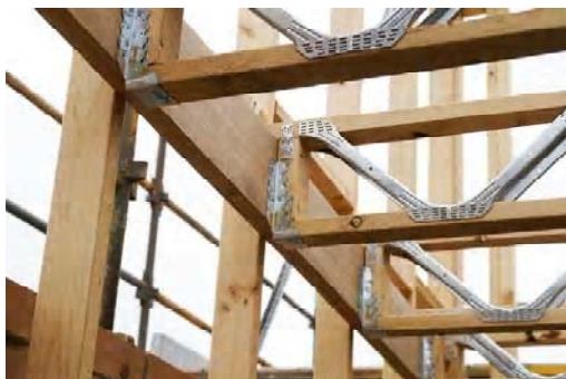
Рисунок 3. Металлодеревянная ферма с решеткой из кронштейнов.
