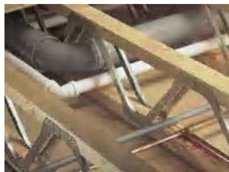
Рисунок 4. Технологические коммуникации в межферменном пространстве.
