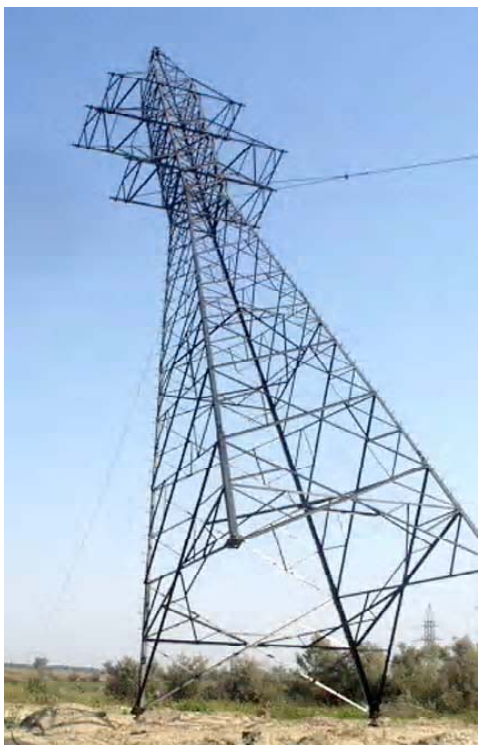
Рисунок 3. Оптимальная анкерно-угловая опора У110-2+14 в процессе монтажа.
