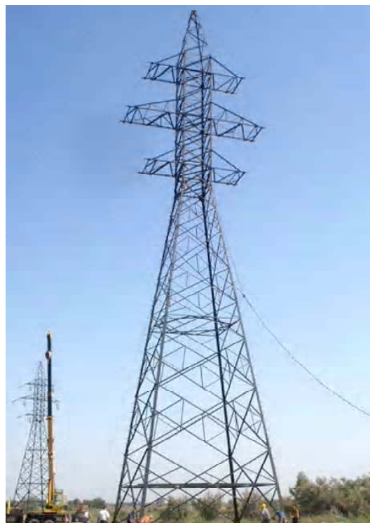
Рисунок 4. Общий вид смонтированной оптимальной опоры У110-2+14.
