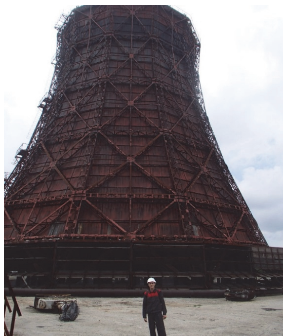
Рисунок 1. Башенная металлическая градирня гиперболической формы площадью орошения 1 600 м 2 .
