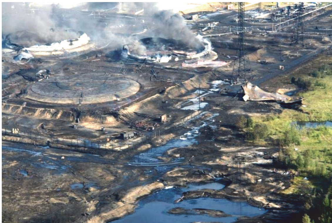
Рисунок 1. Последствия аварийного разлива нефтепродуктов, вызвавшее разрушение технологического оборудования и загрязнение почвы.
