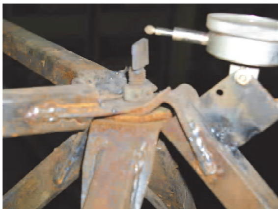
Рисунок 10. Потеря устойчивости гнутой фасонки опорного раскоса в узле 9.
