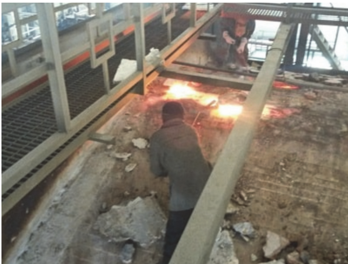
Рисунок 2. Горячий ремонт разделка прогаров по главному своду стекловаренной печи.
