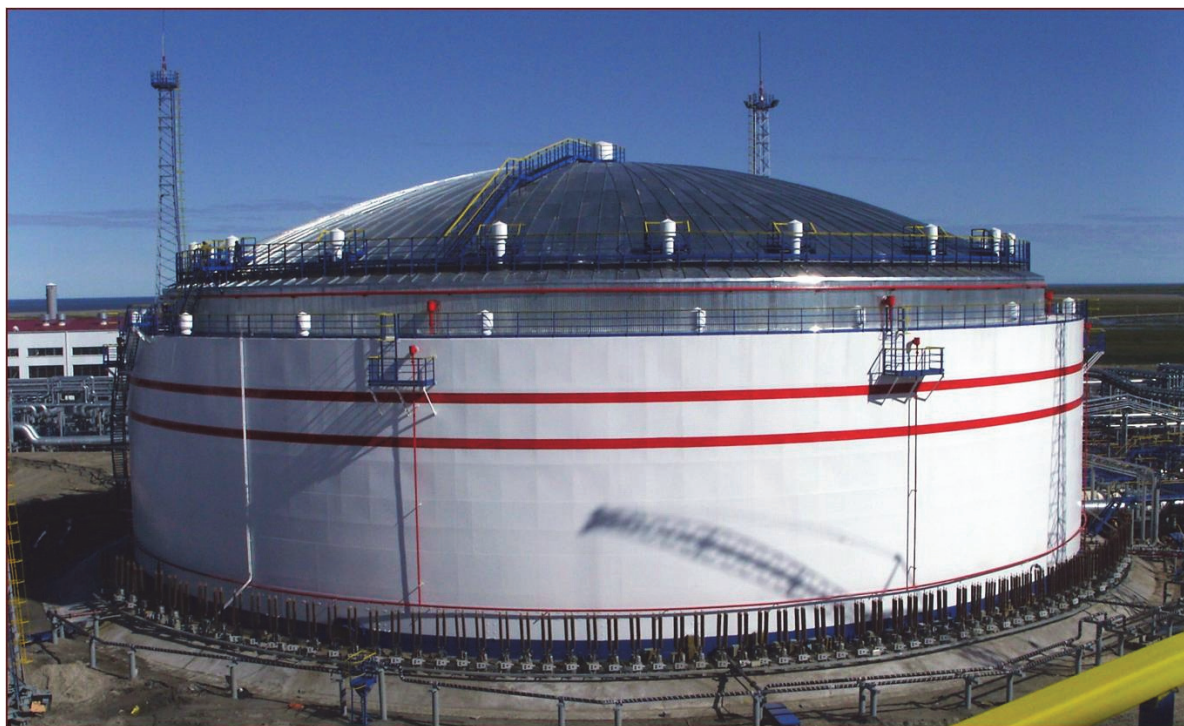
Рисунок 1. Вертикальный цилиндрический резервуар.
