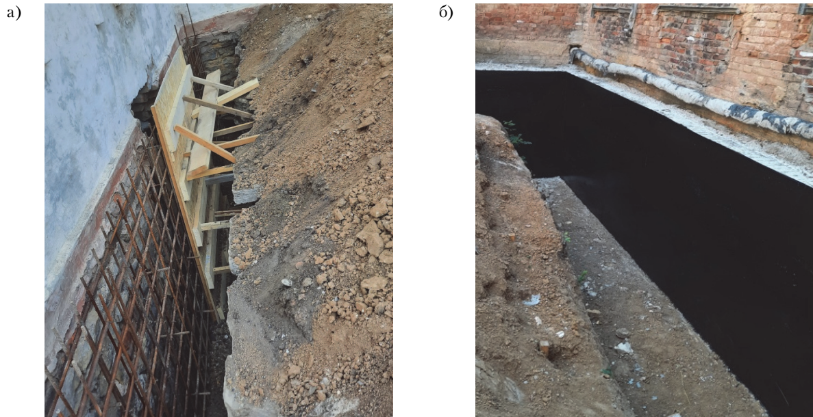
Рисунок 6. Этапы выполнения железобетонных обойм на фундаментах из бутового камня: а) устройство односторонней обоймы по оси «А» в осях «1–2» – армирование и установка опалубки; б) готовая двухсторонняя обойма в осях «2–3» и «А–Б», выполнена вертикальная гидроизоляция.
