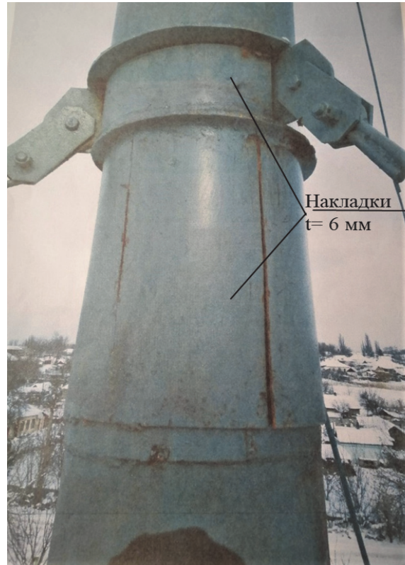
Рисунок 12. Усиление лацменного узла накладками.
