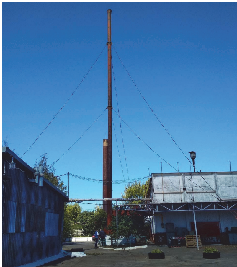
Рисунок 1. Общий вид стальной дымовой трубы высотой 31,8 м.
