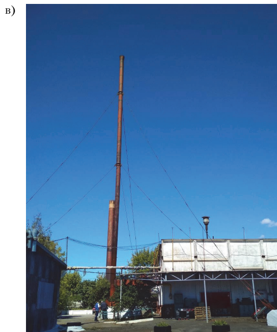
Рисунок 2. Характерные дефекты и повреждения стальной дымовой трубы: а) коррозионный износ нижней обечайки ствола; б) разрушение лакокрасочного слоя ствола трубы с образованием поверхностной коррозии; в) ненормативный крен ствола трубы; г) ненормативное провисание оттяжек.
