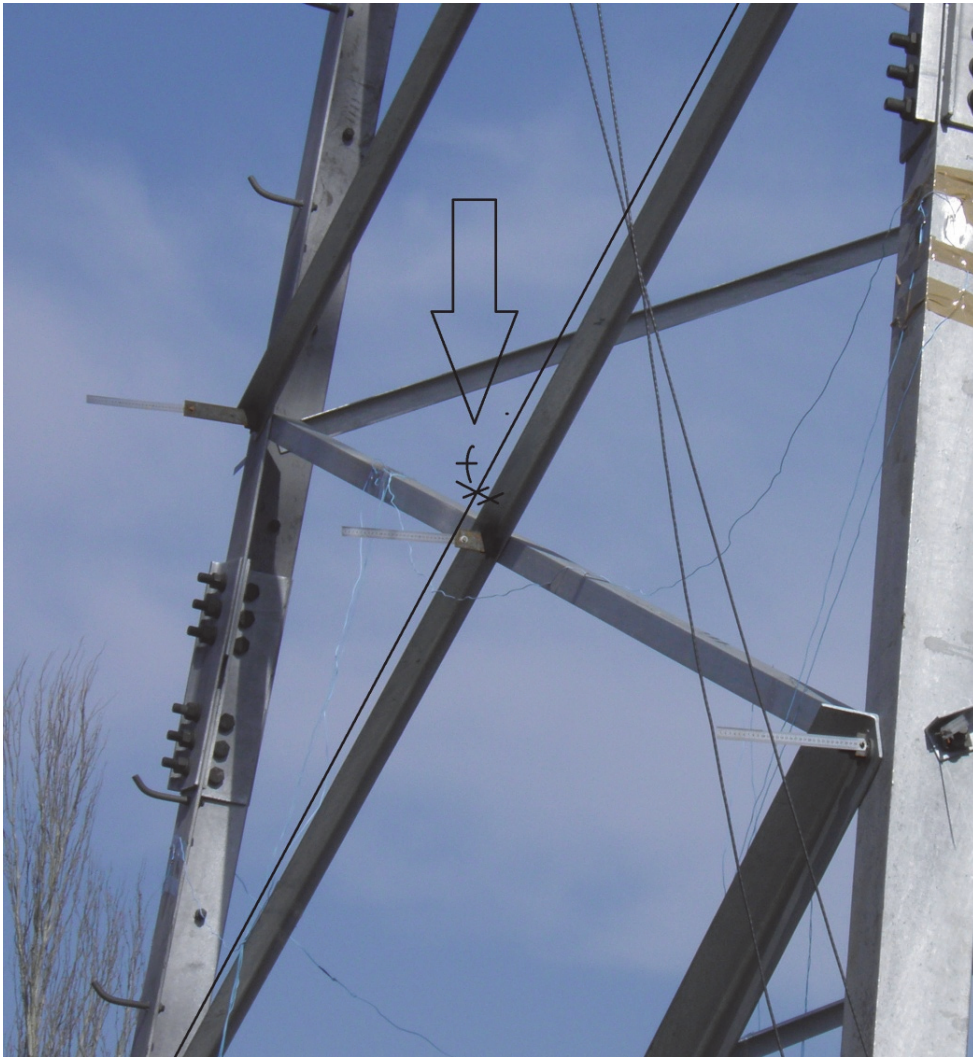
Рисунок 3. Фиксирование выгиба решетки нижней части опоры.
