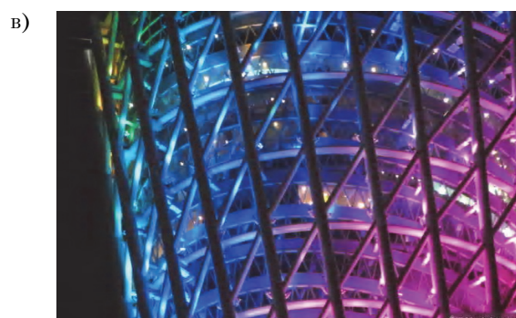
Рисунок 5. Телебашня «Canton Tower» высотой 600 м (г. Гуанчжоу): а) общий вид башни; б), в) оболочка из трубобетонных элементов.
