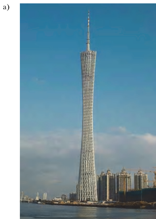
Рисунок 5. Телебашня «Canton Tower» высотой 600 м (г. Гуанчжоу): а) общий вид башни; б), в) оболочка из трубобетонных элементов.
