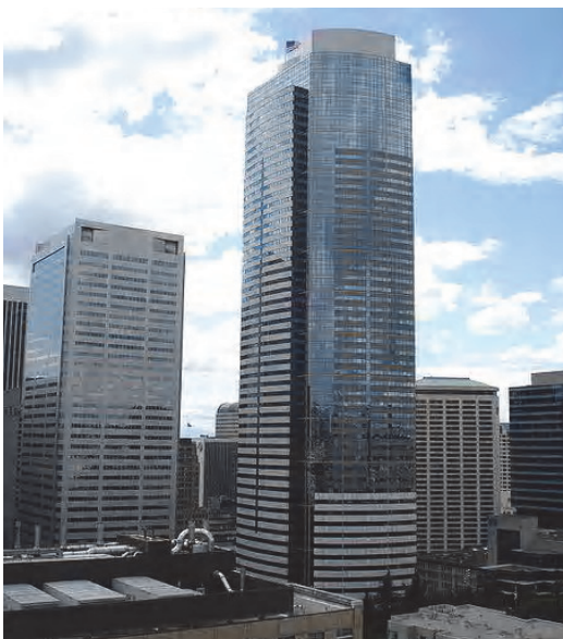
Рисунок 6. 58-этажное высотного здания «Two Union Square» построенное по системе «SWMB» (г. Сиэтл, США): а) общий вид здания; б) план типового этажа.
