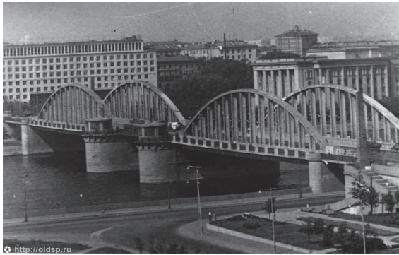
Рисунок 1. Мост через Неву с арками из многотрубного трубобетона.
