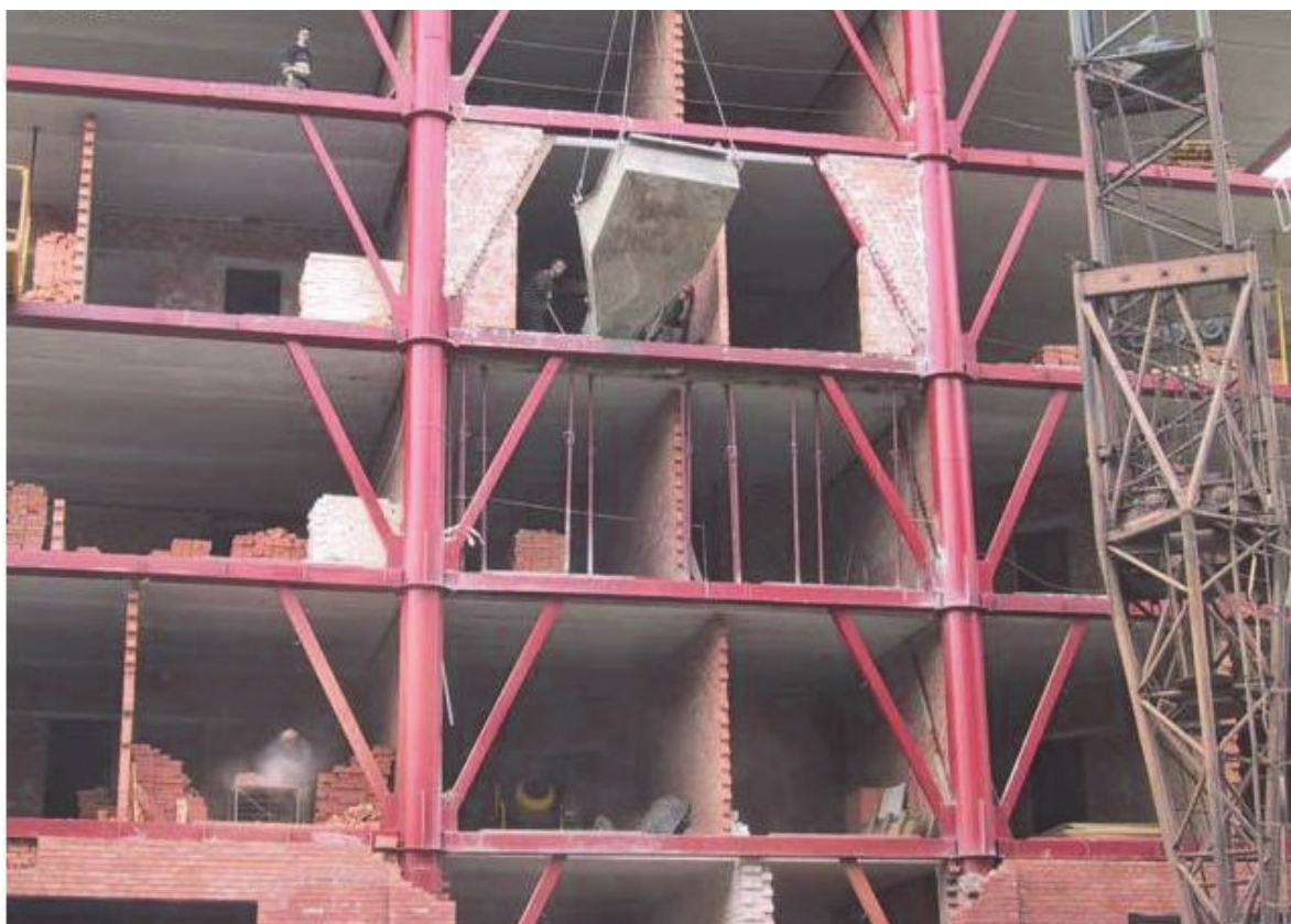
Рисунок 9. Общий вид каркаса здания со стойками из трубобетона в Украине.
