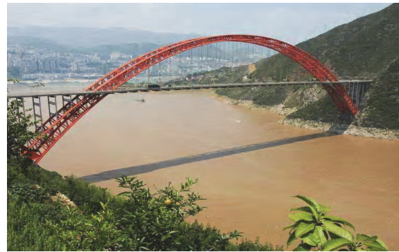
Рисунок 2. Трубобетонный арочный мост Chongqing Wushan Bridge.
